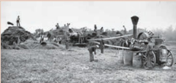
**Stationäre Dreschmaschine** mit Dampfmobile verbunden. Da der Funkenwurf der Dampfmaschine einen Brand auslösen konnte, stellten die Landarbeiter die Maschine in einem Sicherheitsabstand zum gemähten Getreide auf. Fotografie, Red River Valley, Montana, USA, 1878.
