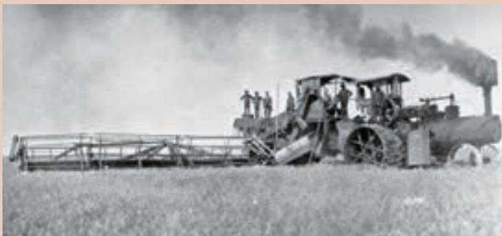
**Mäh- und Dreschmaschine.** Dies war einer der ersten Combines (engl. kombinierte Maschine), der aber noch von einem Dampfmobile gezogen wurde. Fotografie, nördlich von Denton, Montana, USA, ca. 1900.
