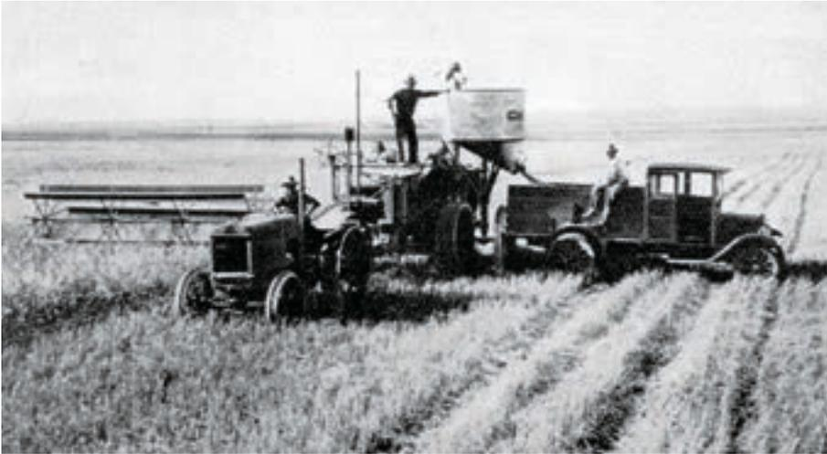
**Technischer Fortschritt.** Umladen des Getreides aus dem Behälter des Mähdreschers auf einen Lastkraftwagen. Auf den riesigen Feldern der USA wurden Mähdrescher mit grosser Schnittbreite eingesetzt. Die Kraft ihres Motors reichte nur für das Schneiden und Dreschen. Ein Traktor musste die Maschine übers Feld ziehen. Fotografie, 1920er Jahre.
